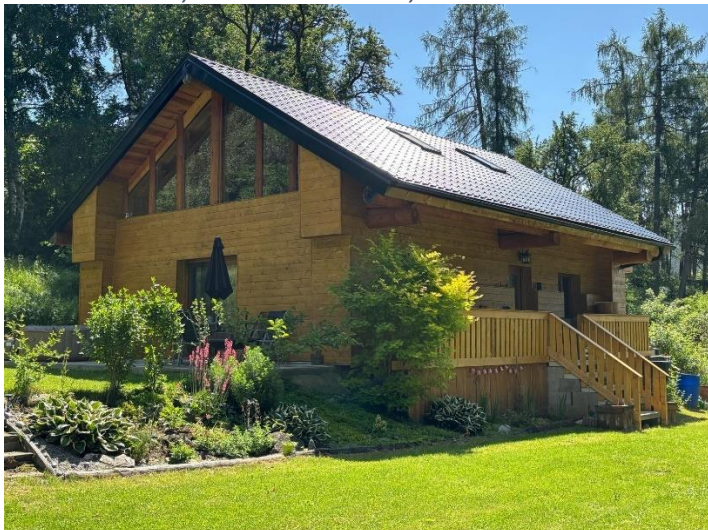
Obrázek 3: Nová výstavba v obci – dřevěný srub
